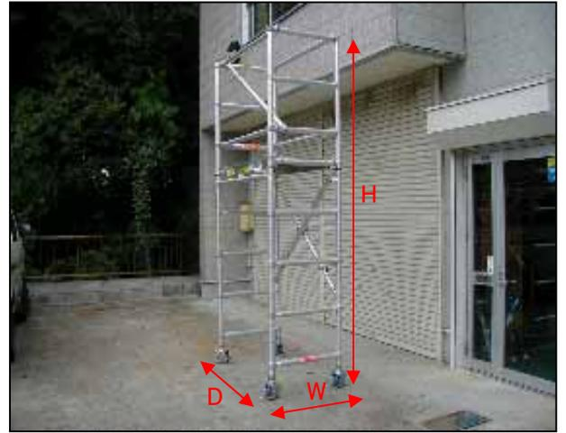
1段の設置寸法：877(W) × 1490(D) × 3280(H)
